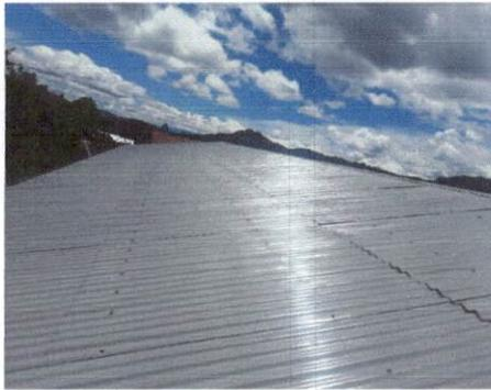
Foto 3: Lijado y aplicación de Pintura anticorrosiva color gris dos pasadas en techo de aulas segundo nivel, modulo 2
