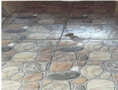
Foto 5: Colocación de piso en el baño
