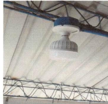
Foto 4: Cambio de plafoneras e instalacion de lamparas led 40 watts
