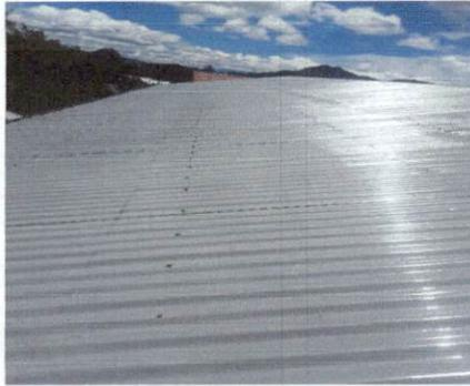
Foto1: Lijado y aplicación de Pintura anticorrosiva color gris dos pasadas en techo de aulas segundo nivel, modulo 2
