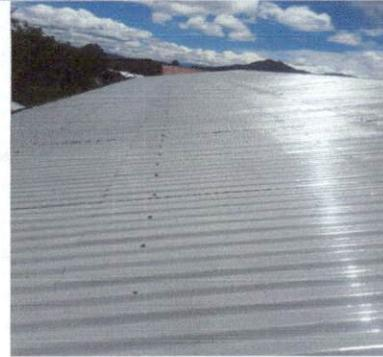
Foto 2: Lijado y aplicación de Pintura anticorrosiva color gris dos pasadas en techo de aulas segundo nivel, modulo 2
